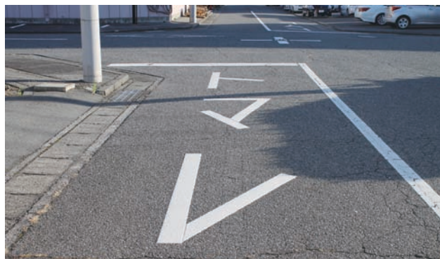
(株)甲府情報システム 北東の交差点に設置された「トマレ」の標示
