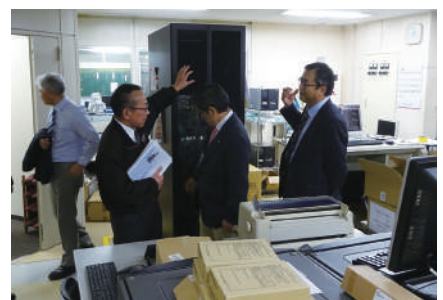
(株)共同電算センターサーバー室等を確認
